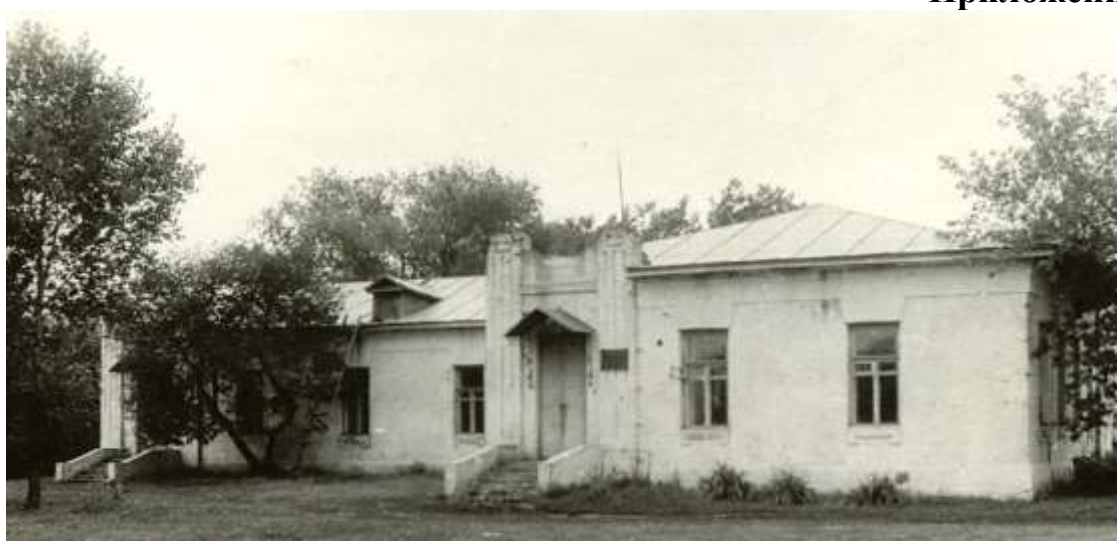
Здание больницы в селе Новочеркутино, фотография 90-х годов XX века, в настоящее время разрушено.
